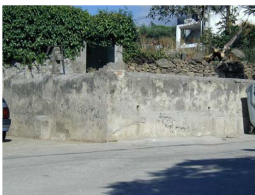
Primer depósito para Abastecimiento.
